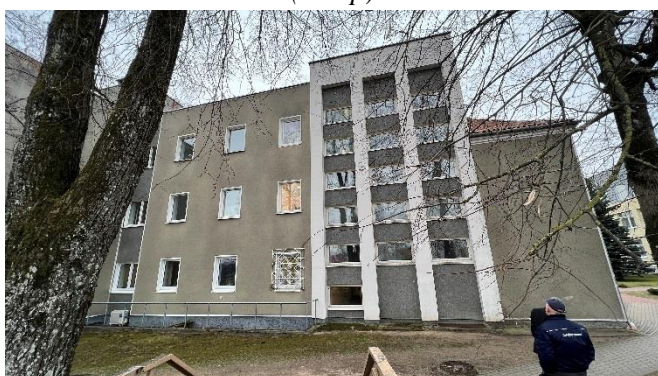
4 pav. Remontuojama pastato dalis iš šiaurinės pusės (6D4p)
