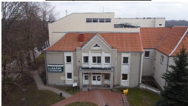
2 pav. Remontuojama pastato dalis iš vakarų pusės (6D4p)
