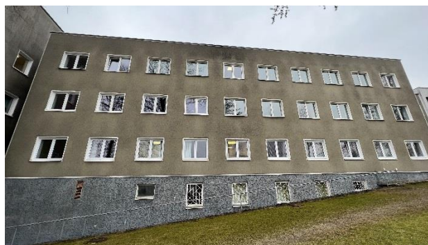
3 pav. Remontuojama pastato dalis iš šiaurinės pusės (6D4p)
